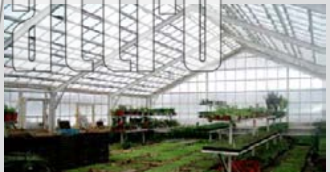
ТЕПЛИЧНЫЙ КОМПЛЕКС ПРИ КАЗАНСКОМ ГОСУДАРСТВЕННОМ АГРОНОМИЧЕСКОМ УНИВЕРСИТЕТЕ. Применялся 8 мм лист сотового поликарбоната прозрачного цвета.
