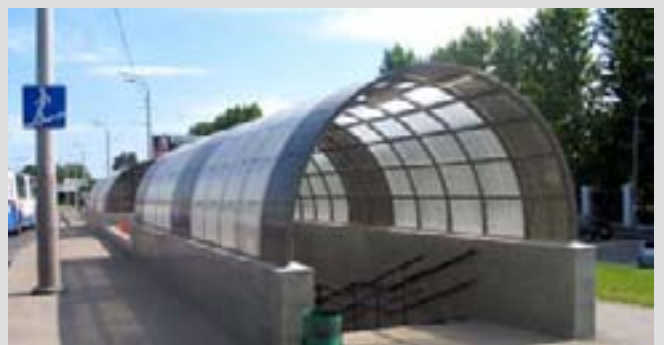
ПОДЗЕМНЫЙ ПЕШЕХОДНЫЙ ПЕРЕХОД (г. КАЗАНЬ). Применялись листы 6 мм сотового поликарбоната прозрачного и бронзового цвета.
