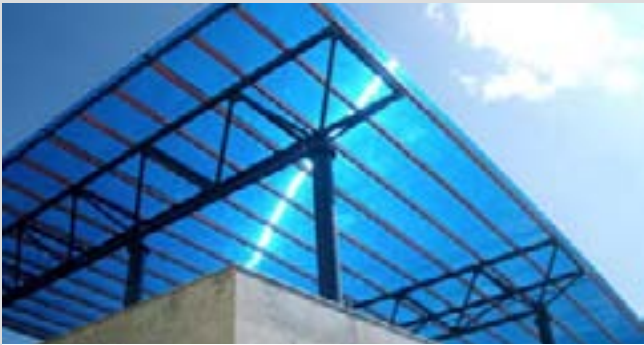
Ж/Д СТАНЦИЯ (г. КАЗАНЬ, ЮДИНО). Применялся 16 мм лист сотового поликарбоната синего цвета.
