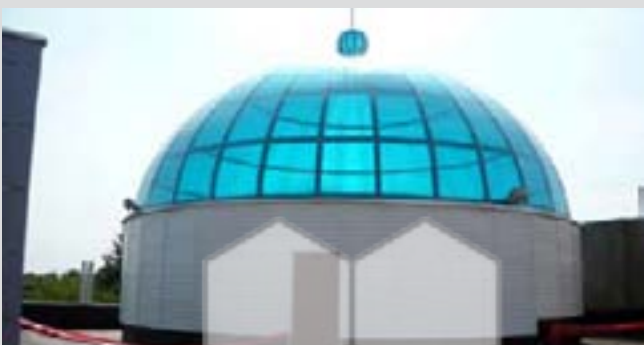
ОФИСНЫЙ ЦЕНТР (г. БРЯНСК). Применялся 8 мм лист сотового поликарбоната бирюзового цвета.
