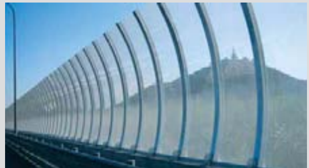
Защитное ограждение автодороги в городе Пекин. Применялся 6 мм прозрачный лист монолитного поликарбоната.
